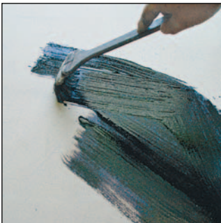
5. Application du Primer SK sur support sec et non ou peu poreux.
