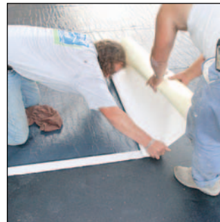
7. Pose de la membrane SK autocollante.
