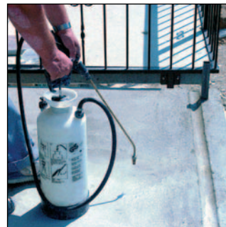
3. Humidification du support minéral.
