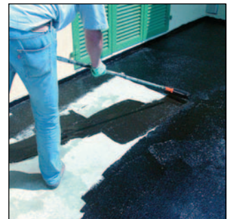
4. Application du Primer K100 sur support humide.
