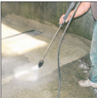
1. Nettoyage et/ou dégraissage du support.
