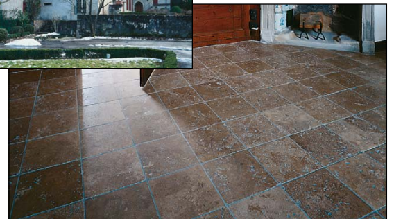
Application de Siloxan sur catelles en terre cuite au château de Bioley-Magnoux. Travaux exécutés en 1998
