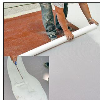
8. Après séchage, dérouler notre toile d'armature et la recouvrir d'**Elastoméтал** à raison de 1 kg/m<sup>2</sup>. Laisser sécher 24 heures.
