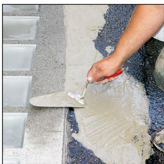
2. Si nécessaire, ragréer le support au **Quellmörtelschnell**, épaisseur max. 17 cm par passe.
