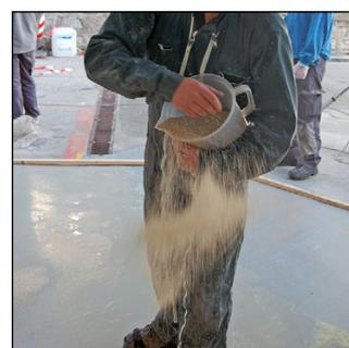
**16.** Sabler dans la couche fraîche. Surface carrossable : sable de quartz granulométrie 0,8 à 1,2 mm, 7 kg/m<sup>2</sup>. Sinon sable de quartz granulométrie 0,6 à 0,8 mm, 4 kg/m<sup>2</sup>.
