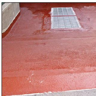
**9.** Appliquer une 3<sup>e</sup> couche d'**Elastométal**, de manière que la structure du voile ne soit plus visible. Consommation : 0,5 à 1 kg/m<sup>2</sup>.
