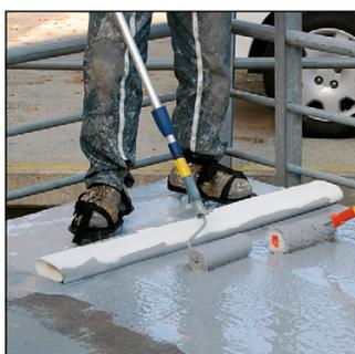
**14.** Appliquer le bicouche d'entoilage, au **Kemco V 210** ou **Kemperol 2C** à raison d'env. 2,5 kg/m<sup>2</sup>.
