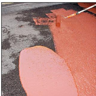
6. Appliquer la 1<sup>re</sup> couche d'**Elastoméтал**, à raison de 150 g/m<sup>2</sup>. Si support très absorbant, diluer avec 25 % d'eau, sinon pur.
