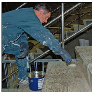
**10.** Appliquer le **Primer EP** ou **D**, en une couche au rouleau, à raison de 0,3-0,5 kg/m<sup>2</sup>.
