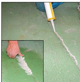
3. Assainir les différents joints de dilatation, les relevés et les obstacles avec l'**Elastofill/Scotch**.
