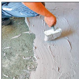
5. Pose manuelle: à la brosse de maçon en 2 couches « frais sur frais », délai max. 2 heures entre les couches, consommation 3 à 4 kg/m<sup>2</sup> au total.
