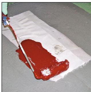
7. Appliquer notre voile de pontage triple aux joints de dilatation, aux relevés et aux obstacles au moyen de l'**Elastoméтал**.
