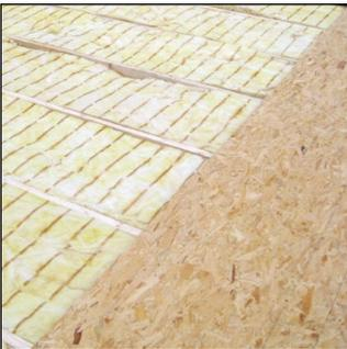
**Option:** mise en conformité de l'isolation thermique à la norme SIA 381/1. Pose de l'isolation thermique et d'un plancher OSB.
