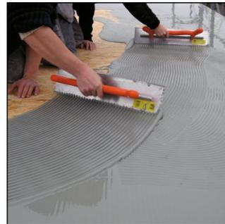
Application au plâtre à colle (lisseuse), denture 8 mm, de l'**Aqua Blocker**® (bleu).
