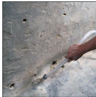
2. Nettoyer soigneusement les trous à l'aide d'un aspirateur.
