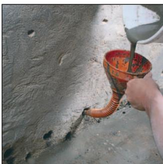
5. Obstruer ensuite les forages remplis de minéralisant par le ciment expansif spécial **Bohrlochschlämme**, riche en calcaire, qui durcit en quelques minutes.
