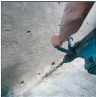
1. Sur env. 10 cm de hauteur, forer des trous de 28 mm de diamètre en quinconce, inclinés à 45° sur une profondeur égale aux deux tiers de l'épaisseur du mur.
